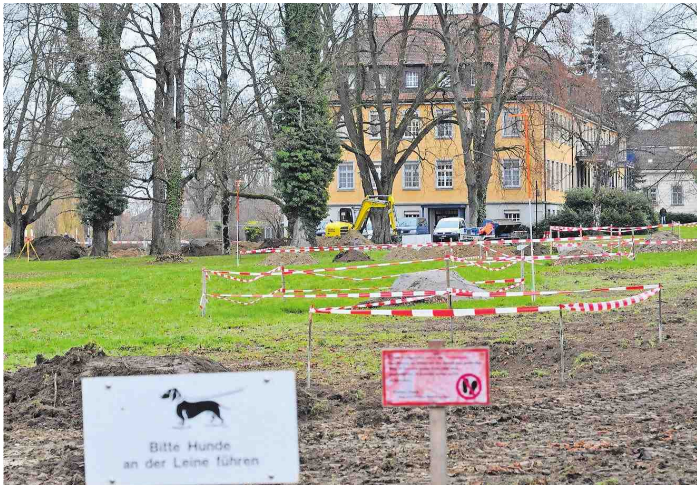
Im Westteil der Psychiatrischen Klinik Münsterlingen entsteht eine provisorische Therapiestation.
