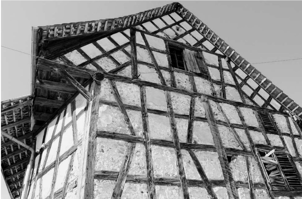
Bald wird die Baudirektion die Sanierung des Girsbergerhauses in die Wege leiten.
